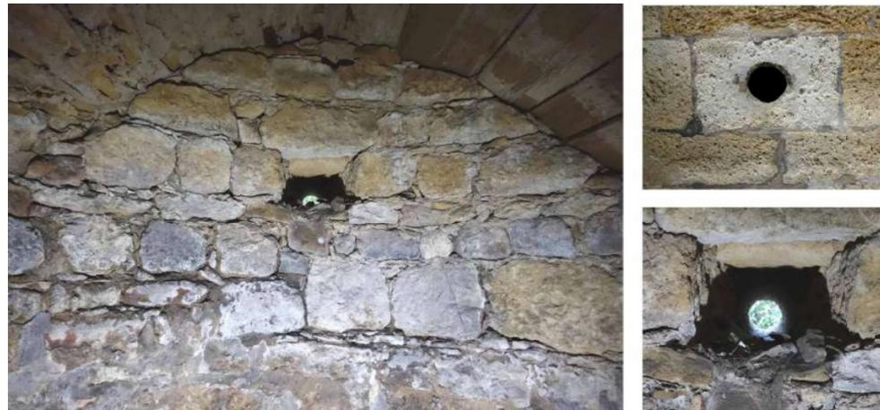
**Abb. 10:** Karner Hartberg, Untergeschoß Apsis, Oculus von außen und innen (Durchmesser Oculus 13 cm, Höhe über Gelände 1.06 m, Werkstein wie Bandrippen). Im unteren Bildteil ist eine Arbeitsfuge („ausgewickelte“ Schar) erkennbar; unterhalb ist das Mauerwerk verputzt (vgl. **Abb. 9**) und oberhalb steinsichtig. Die Schalungsbretter des Tonnengewölbes sind zum Teil noch vorhanden (linkes Bild, rechts oben).
