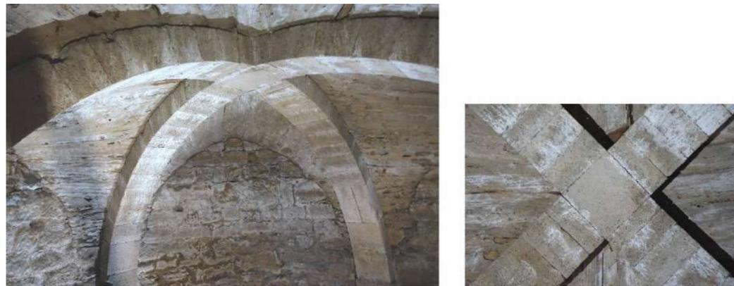
**Abb. 7:** Karner Hartberg, Ossarium, Bandrippen mit Schüttgewölbe und quadratischem
