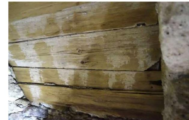
**Abb. 33:** Karner Hartberg, Schalungsbretter des Schüttgewölbes über dem Untergeschoß Apsis.
