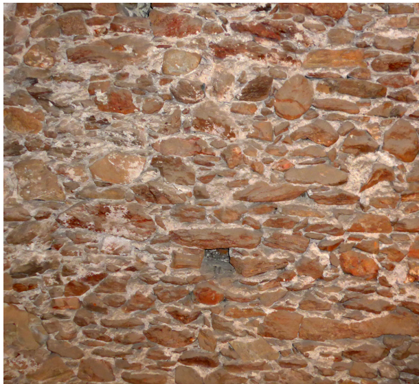
Abb. 18: Pfarrkirche Friedberg, Mauerwerk der westlichen Giebelwand im Dachboden (wahrscheinlich in gleicher Weise auch im übrigen verputzten Mauerwerk)
