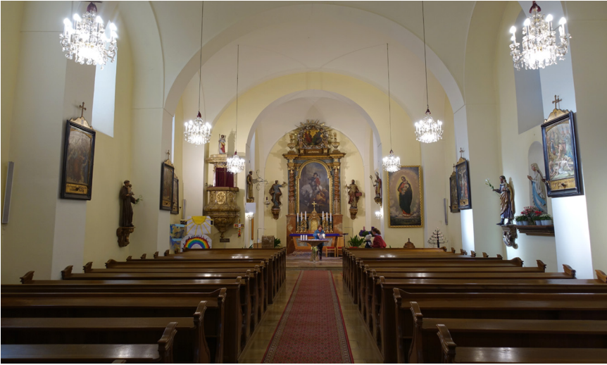
Abb. 28: Pfarrkirche Fischau, Innenansicht mit Platzlgewölbe, Gurtbögen und Wandpfeilern (Einbau 1798 im barock-klassizistischen Stil)
