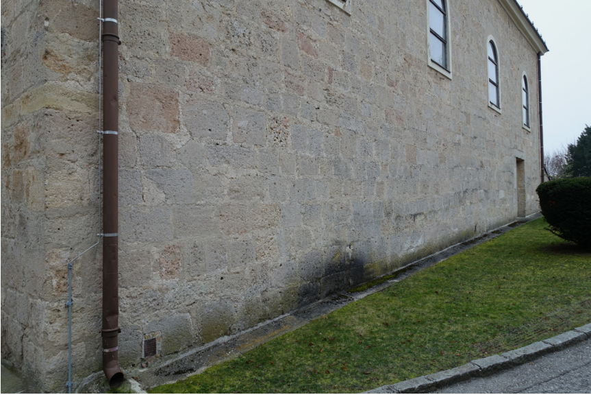
Abb. 32: Pfarrkirche Fischau, Mauerwerk Langhaus (Nordseite)
