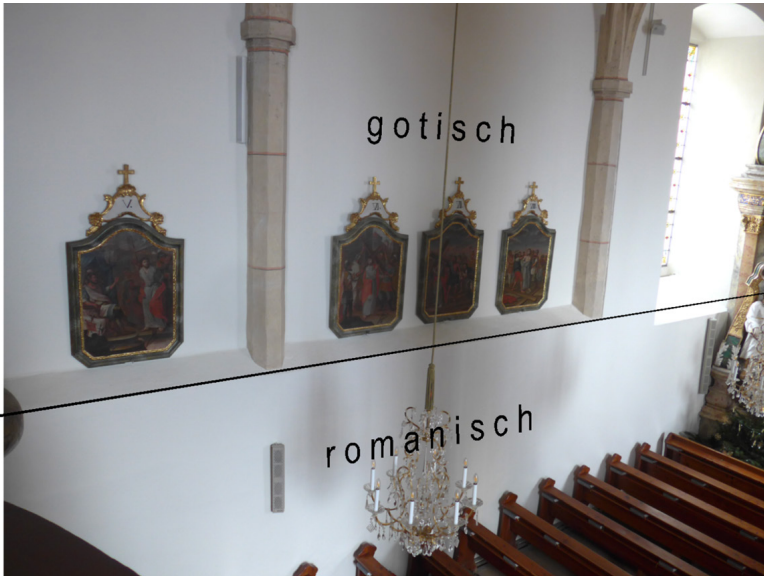
Abb. 15: Pfarrkirche Friedberg, Langhaus, Mauerabsatz an den Außenwänden (ab Fensterparapet gotischer Umbau)
