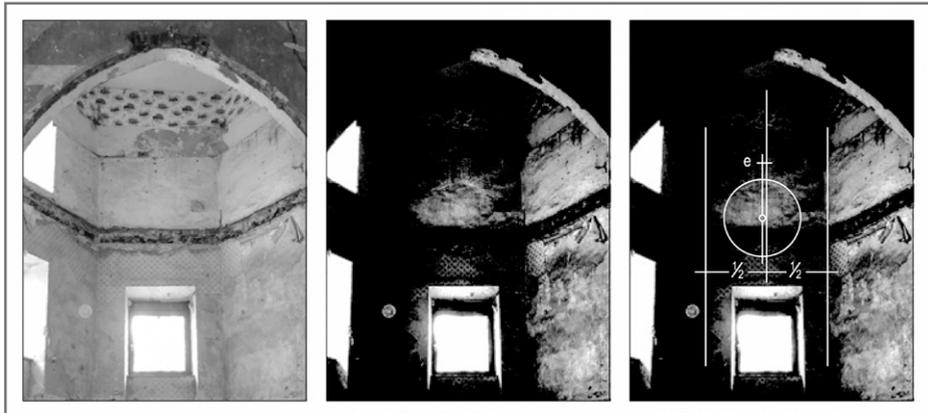
Abb. 17: Bruck an der Mur, Heiliggeistkirche, Blick in die SO-Altarnische. Im oberen Bereich zeichnet sich eine kreisförmige Fläche ab, die auf ein zugemauertes Ostfenster hinweisen könnte. Zur Verdeutlichung ist im mittleren Bild der Kontrast verstärkt. Rechts davon wird aufgezeigt, dass dieser Kreis aus der Mitte der Wand nach Norden verschoben ist.
