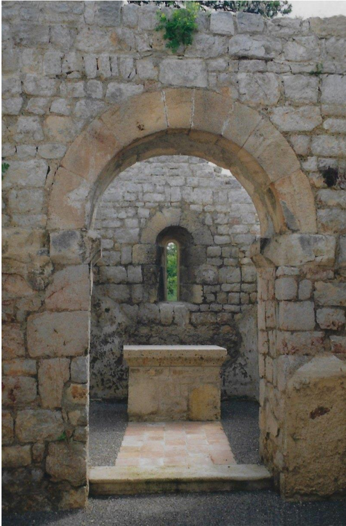
Abb.12: Burgkapelle Emmerberg, 2003, Innenansicht nach Bestandssicherung (vgl. Außenansicht Abb.10). Der Hauptaltar wurde wieder aufgebaut, von der Ostwand abgerückt und mit einer neuen Mensaplatte ausgestattet; die beiden Seitenaltäre wurden entfernt.
