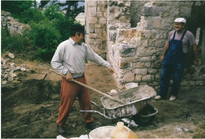
Abb.36: Burgkapelle Emmerberg, Leopold Grund und Herbert Hochhauser beim Mischen des Mauermörtels.
