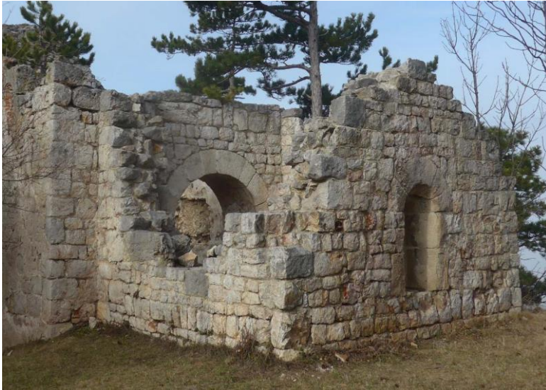
Abb.10: Burgkapelle Emmerberg, 2003, Außenansicht von Südosten nach Bestandsicherung mit Ergänzungen (vgl. Abb.9)
