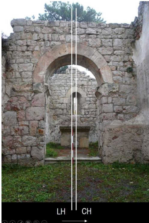
Abb.17: Burgkapelle Emmerberg, die Achse Chor (CH) weicht gegenüber der Achse Langhaus (LH) nach Süden ab. Die Winkeldifferenz wird als „Achsknick“ bezeichnet.
