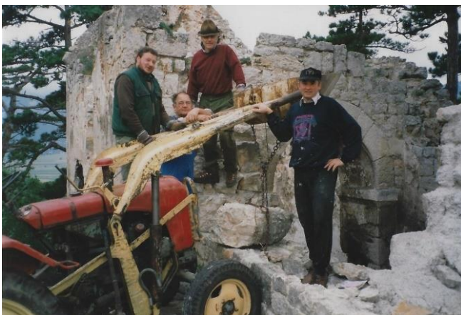
Abb.37: Martin Schmölz, Herbert Hochhauser, Walter Reidinger und Leopold Grund beim Versetzen eines schweren Steines am 19. September 1998, den die „Steinräuber“ nicht brauchen konnten (Original am ehemaligen Ort wieder eingebaut).
