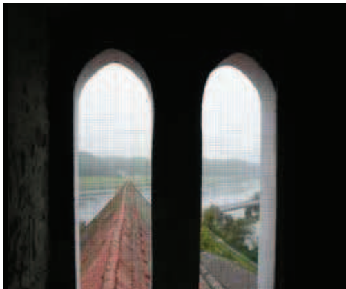
Abbildung 7: Der Anschluß des Langhausdaches an den Kirchturm – der Achsknick zwischen Langhaus und Turm führt zur Verschiebung aus der Mitte nach Westen. Der Blick aus dem Turmfenster zeigt die Abweichung besonders deutlich.
