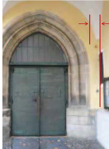
Abbildung 8: Die Turmdrehung bewirkt im Portalbereich unterschiedliche Abstände zwischen Turm und Portalgewände (Westportal).
