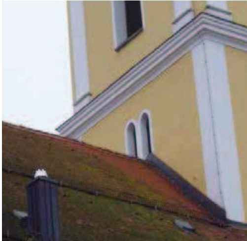
Abbildung 6: Der Anschluß des Langhausdaches an den Kirchturm – der Achsknick zwischen Langhause und Turm führt zur Verschiebung aus der Mitte nach Westen.
