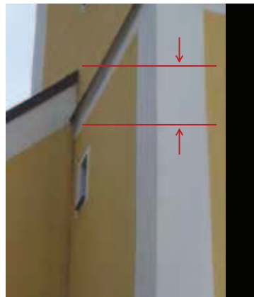
Abbildung 10: Infolge der Turmdrehung und der Nicht-Parallelität der Seitenschiffsmauern schließen die Seitenschiffsdächer in unterschiedlicher Höhe an den Turm an (westliches Seitenschiffsdach).
