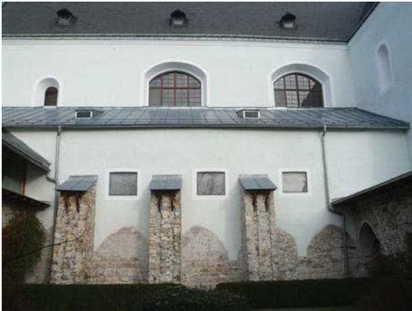
Abb.17: (Klein-)Mariazell in Österreich, Südwand Gründungsbau, Außenansicht mit Spuren des abgebrochenen Kreuzganges und nachträglich errichteten Stützfeilern
