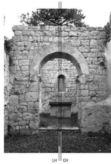
**Abb.9: Burgkapelle Emmerberg, Winzendorf, NÖ, Achsknick nach Süden (romantischer Bestand), Knickwinkel  $2.0^\circ$**
