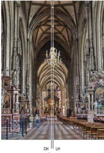
**Abb.6: Dom St. Stephan in Wien, Achsknick nach Norden, romanische Achse bei gotischem Chor übernommen, Knickwinkel  $1.02^\circ$**
