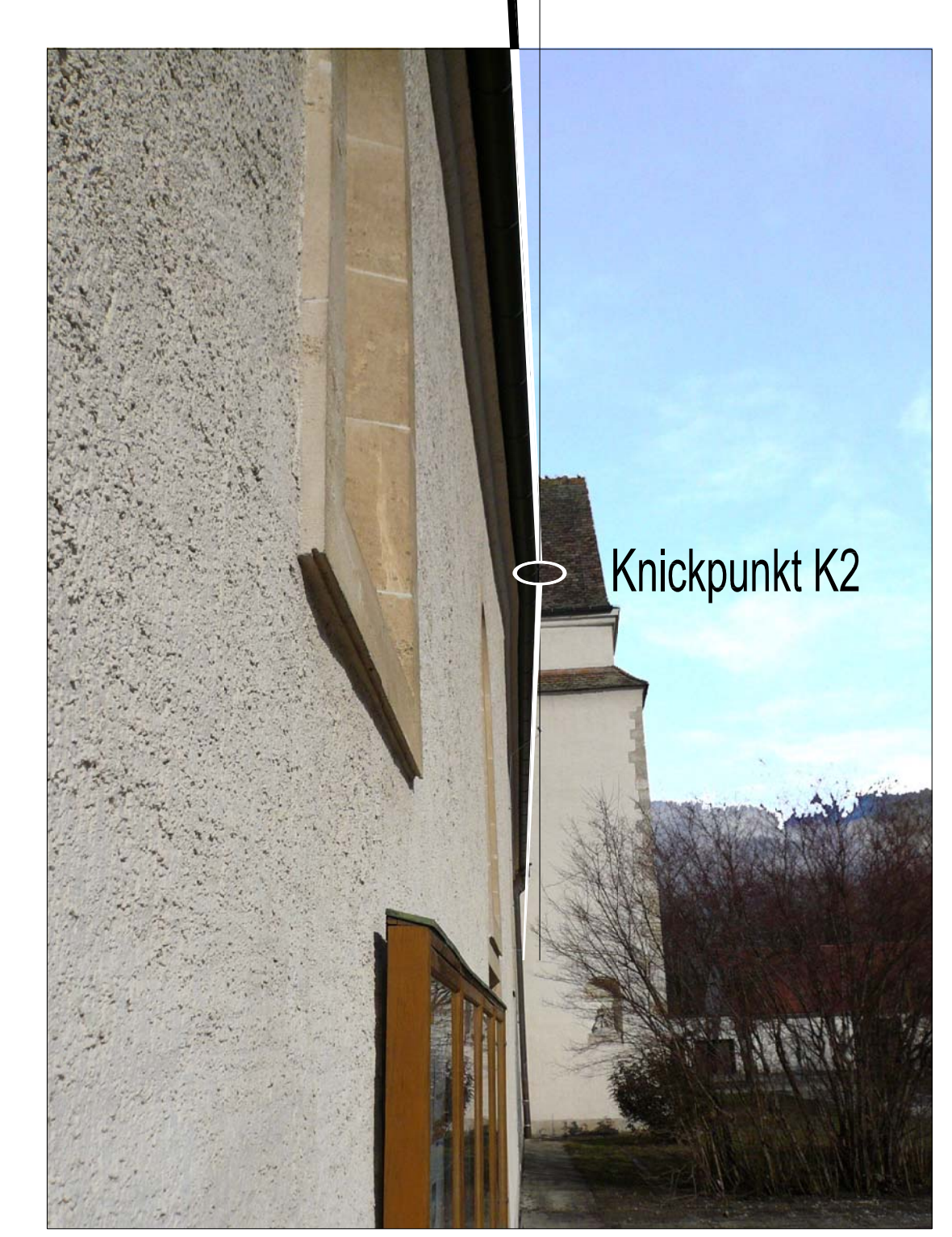
südliche Mauerflucht mit Knickpunkt K2 nördliche Mauerflucht symmetrisch, Knickpunkt K1
