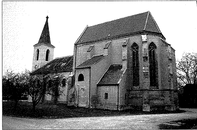
Abb. 13: Marchegg, Stadtpfarrkirche, Ansicht von Süden mit dem gotischen Chor aus der Gründungszeit (1268) und dem später verkürzten Langhaus (Foto: Erwin Reidinger).
