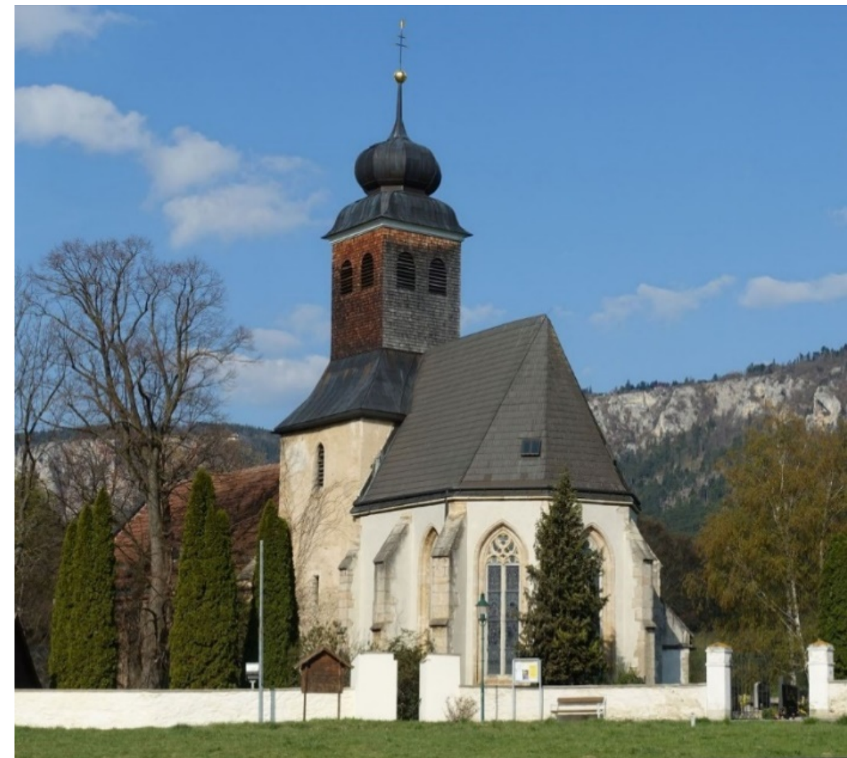
Abb.43: Pfarrkirche Muthmannsdorf, Ansicht von Nordosten, die durch den gotischen Chor dominiert wird.
