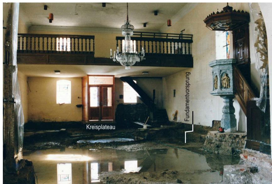
Abb.18: Pfarrkirche Muthmannsdorf, Fundamentvorsprung an der Nordwand des Langhauses und freigelegtes Kreisplateau.
