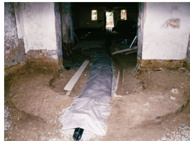
Abb.25: Pfarrkirche Muthmannsdorf, Apsis nach Freilegung
