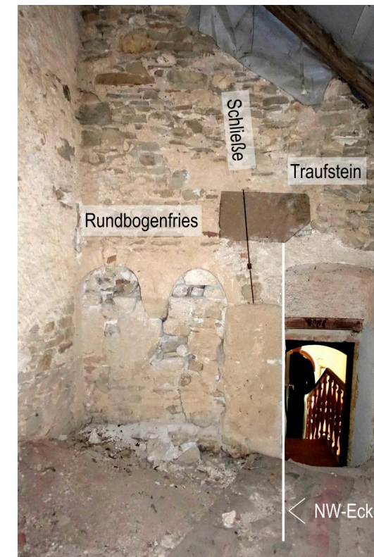
Abb.15: Nordwestliche Ecke der Ausführung mit Rundbogenfries und Traufstein (von Punkt 5L um die Mauerdicke nach Osten verschoben). Romanisches Rundbogenfries und Traufstein erhalten.
