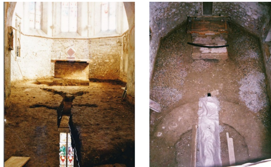
Abb.45: Pfarrkirche Muthmannsdorf, der gotische Chor in zwei Bauphasen der Restaurierung.
