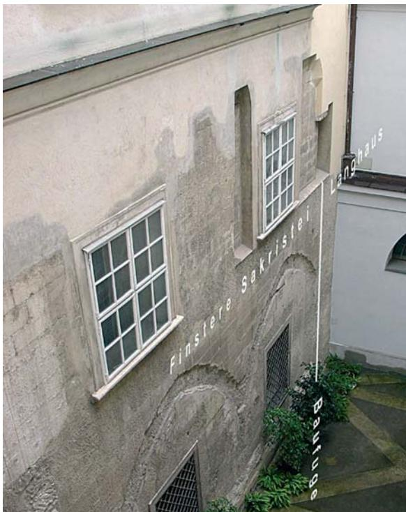
268. Schottenkirche, Steinhöfel, romanische Nordwand im Bereich der Finsteren Sakristei mit Spuren des 1831 abgebrochenen gotischen Kreuzganges. Im Bereich der SW-Ecke des Steinhöfels ist der Versatz (Rücksprung Langhaus) zwischen Finstere Sakristei und Langhaus an der Grenzlinie zwischen Sichtmauerwerk und Verputz (Baufuge) erkennbar (Abb. 254 und 256). Blick nach Westen, 2006
