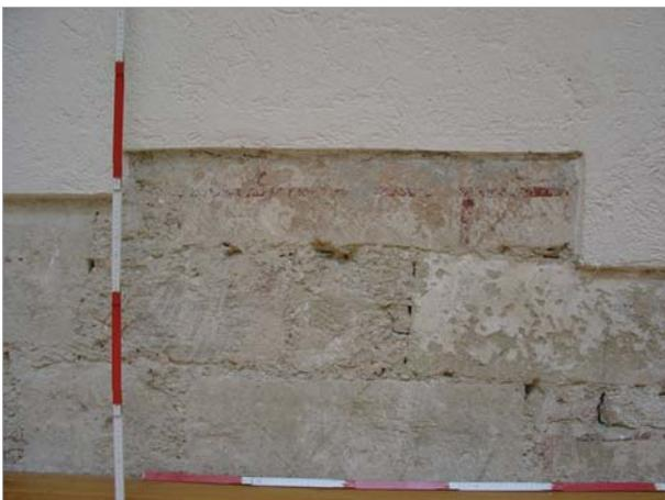
257. Schottenkirche, Schottensaal, barocke Vormauerung mittels romanischer Spolien (Richtung Abb. 254). Die Spolien zeigen Fugenmalereien auf, die auf einzelne Quader beschränkt sind, 2006
