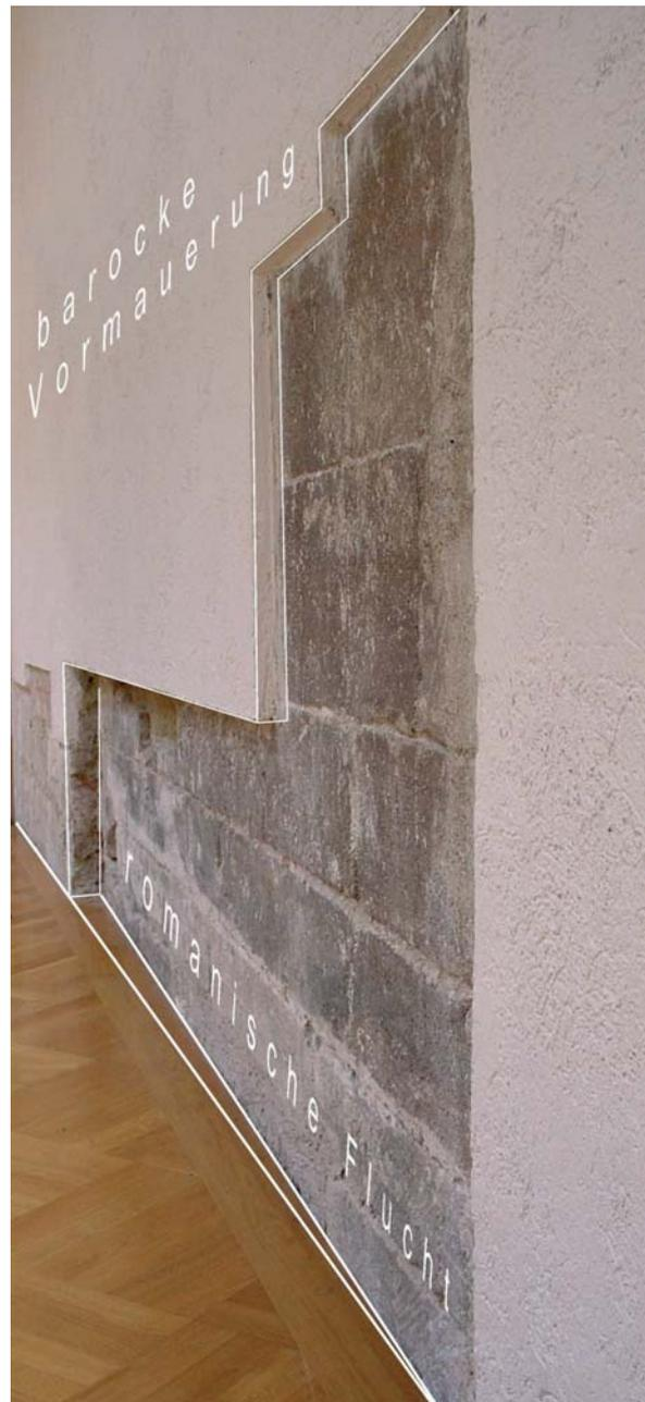
255. Schottenkirche, Schottensaal, Flucht der romanischen Nordwand und jene der barocken Vormauerung (Grundriss und Richtung Abb. 254). Die letzten 3 m sind wegen des spitzen Winkels ausgebrochen; das romanische Quadermauerwerk wurde freigelegt und steinsichtig belassen, 2006.
