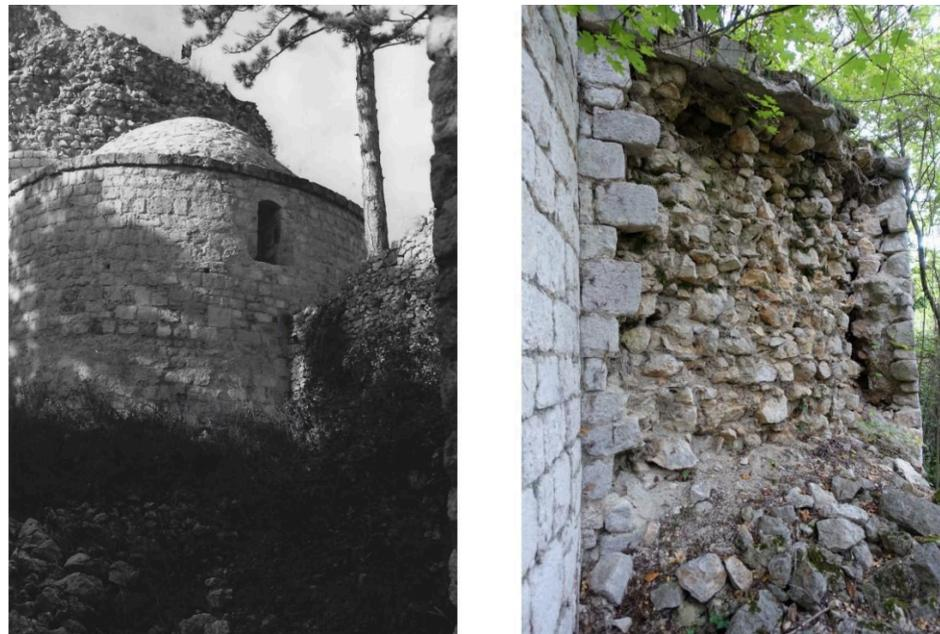
**Abb. 6:** Rundkapelle Starhemberg, Apsis nach Restaurierung 1960 und Bauzustand 2021. Neuerlicher Verlust der Mauerschale.
