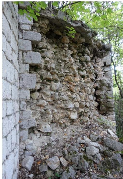
**Abb. 6:** Rundkapelle Starhemberg, Apsis nach Restaurierung 1960 und Bauzustand 2021. Neuerlicher Verlust der Mauerschale.
