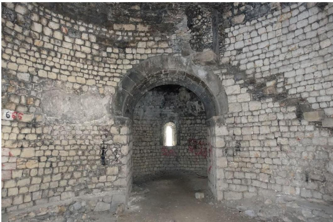
**Abb. 8:** Rundkapelle Starhemberg, Innenansicht Richtung orientierter Achse mit Zentralraum, Apsispforte, Apsis und Apsisfenster sowie dem abgebrochenen Stiegenaufgang ins ehemalige Obergeschoß, 2021.
