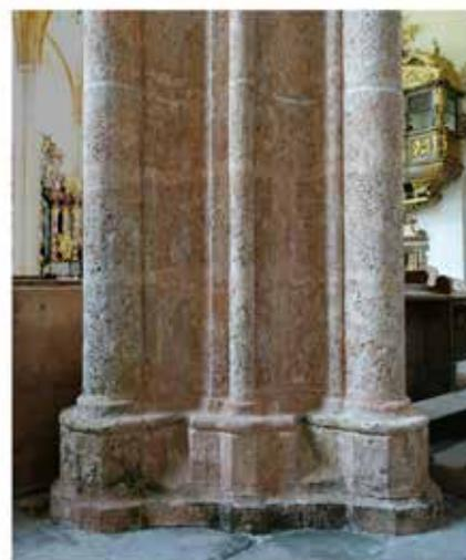
Abb. 14: Vierungspfeiler Konstruktion nach dem Prinzip der Quadratur.
