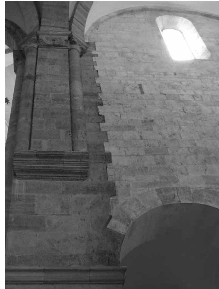
Abb. 28: Baunaht (Verzahnung), durch unterschiedliche Helligkeit der Bauabschnitte 1 (links) und 2 (rechts) verdeutlicht.
