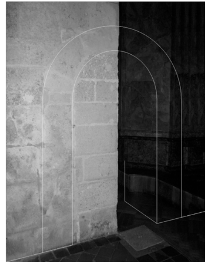
Abb. 20: Rest einer gewölbten Türöffnung in der Nordwand am Beginn des Querhauses (Bau II)
