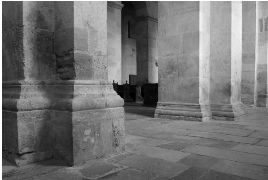
Abb. 19: Langhaus Sockelzone (Abtreppung)
