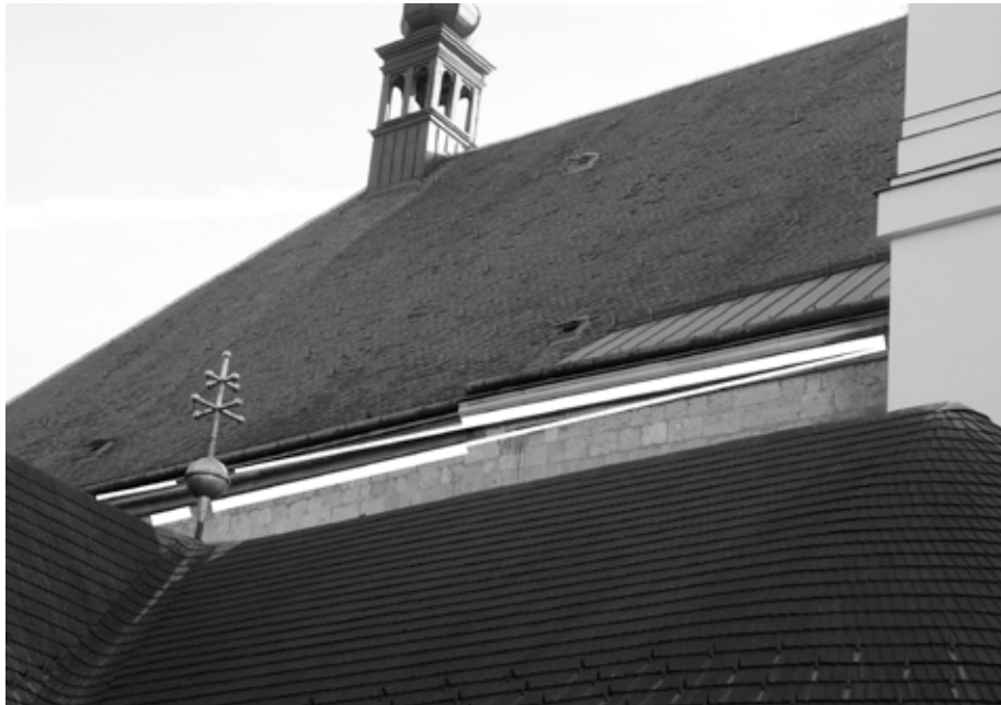
Abb. 25: Nordwand Querhauses (Bau II). Achsknick an den verschiedenen Richtungen der Traufen von Bau II (steht im rechten Winkel auf die schiefe Achse Triumphpforte) und Bau III (gotischer Hallenchor in Achse Langhaus) erkennbar.
