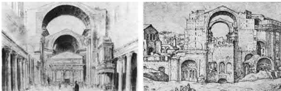
Fig. 22. Stato della costruzione prima e dopo la demolizione della navata, con quadripartizione già realizzata del nuovo edificio, 1533 o 1536 (taccuino di Maarten van Heemskerck), la navata maggiore è mostrata in asse.
