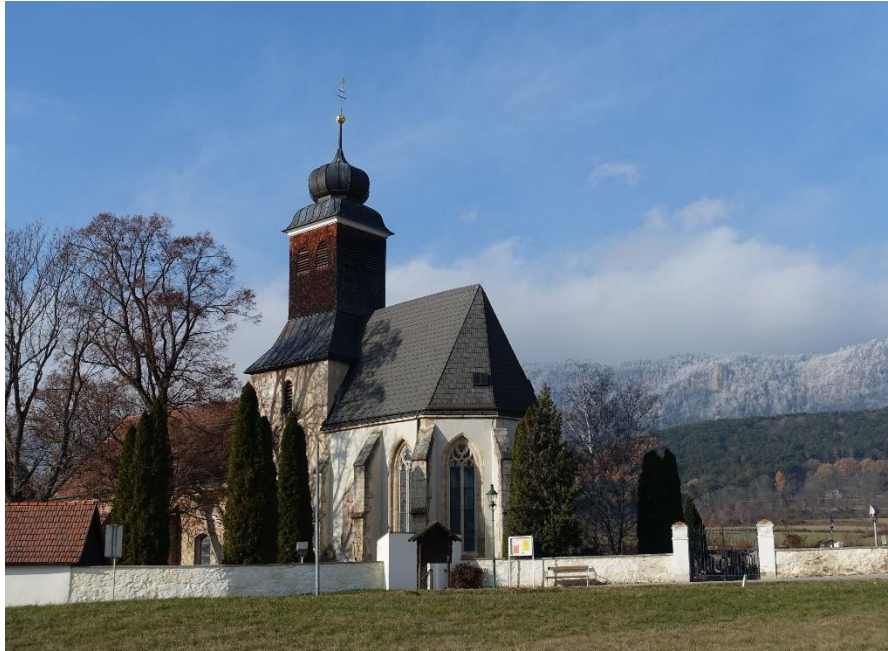
Abb.15: Pfarrkirche Muthmannsdorf, Ansicht von Ost-Nord-Ost mit gotischem Chor aus 1418.
