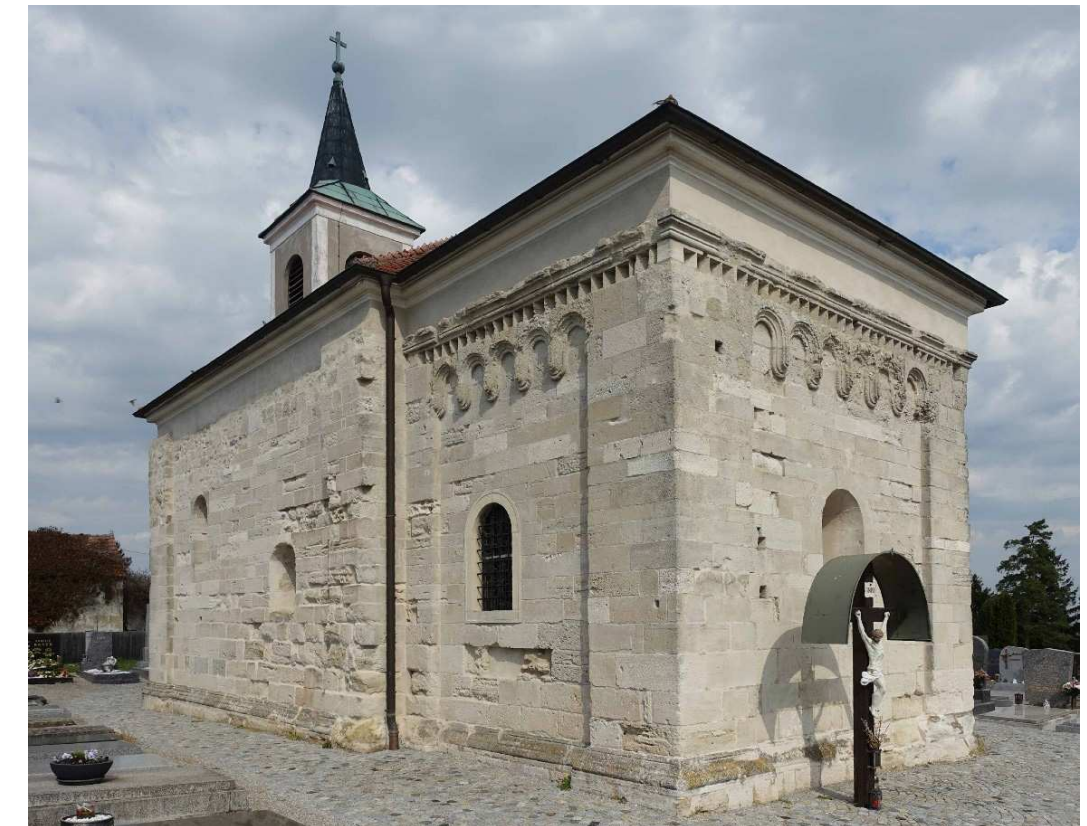
Abb. 16: Flk Wildungsmauer, Ansicht von Südost
