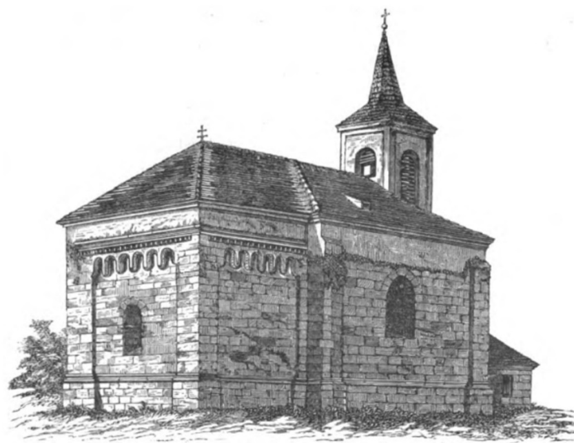
Abb. 5: Kirche von Wildungsmauer 1872, Ansicht von Nordost (Vorlage der Zeichnung war vermutlich das Foto in Abb. 6 )
