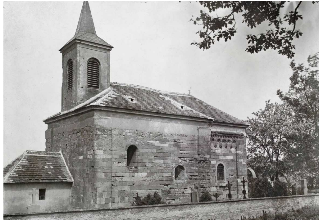
Abb. 10: Flk Wildungsmauer, Ansicht von Süden (ohne Datum)
