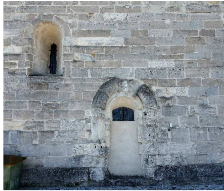
Abb. 18: Flk Wildungsmauer, Nordfassade mit zugemauertem Portal und Trichterfenster
