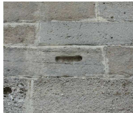
Abb. 20: Abgewittertes Mauerwerk (Ecke Langhaus, Südseite) und nordseitiger Quader mit abgearbeitetem Wolfsloch (Hinweis auf wiederverwendete Quader/Spolien)
