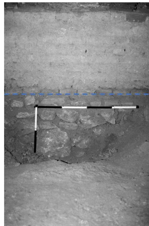
Abb. 24: Flk Wildungsmauer, Dachboden. Die Untersuchung des Mauerwerks ergab keinen Hinweis, der zur Klärung der übermäßigen Mauerdicke führen könnte. Es ist der Bereich der späteren Aufmauerung.
