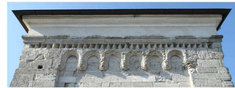
Abb. 21: Flk Wildungsmauer Chor, Rundbogenfries mit Zahnschnitt an der Süd-, Ost- und Nordseite
