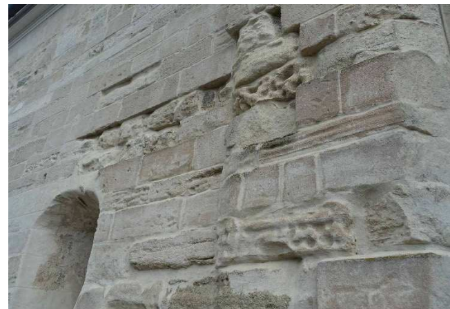
Abb. 20: Abgewittertes Mauerwerk (Ecke Langhaus, Südseite) und nordseitiger Quader mit abgearbeitetem Wolfsloch (Hinweis auf wiederverwendete Quader/Spolien)
