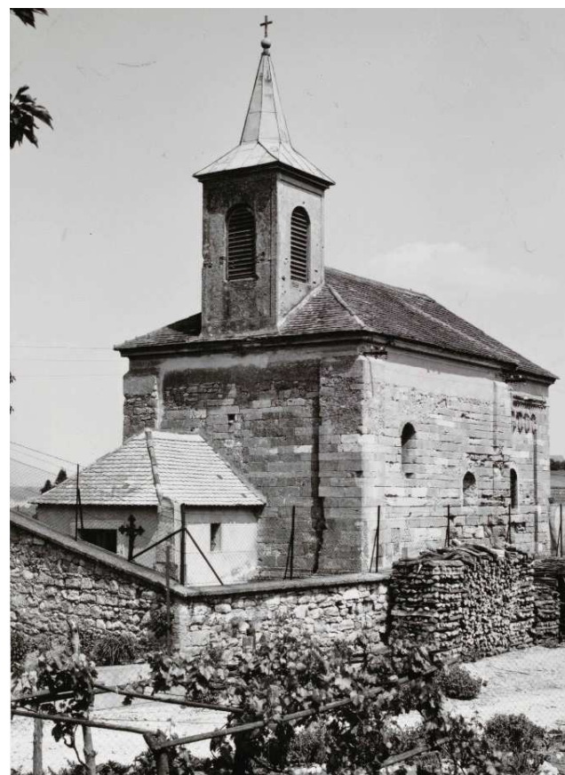
Abb. 11: Flk Wildungsmauer, Ansicht von Westen (ohne Datum)
