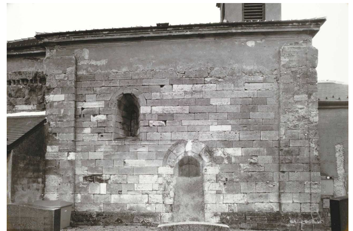
Abb. 13: Flk Wildungsmauer, Nordfassade mit ehem. Nordportal, 1991
