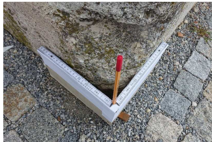
Abb. 19: Abgewitterte Ecke mit Schablobe zur exakten Bestimmung des Eckpunktes
